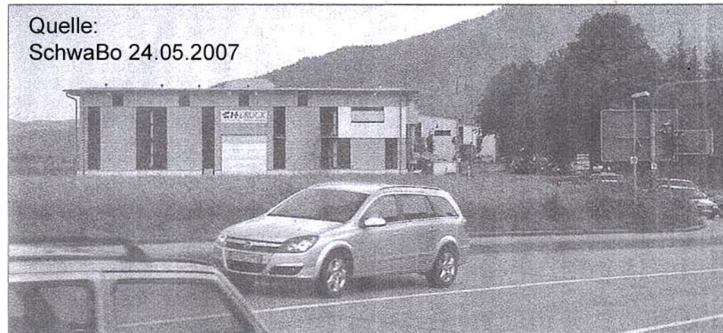
Auf der freien Fläche an der Einmündung der Schleifmattstraße in die B 33 möchte Elektro-Prinzbach Lager, Werkstatt und Verkaufsräume einrichten. Foto: Kempf
